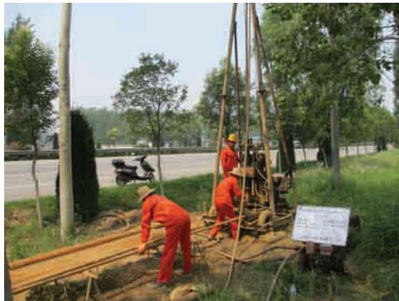
▲徐淮铁路施工 ▲锦白铁路施工
