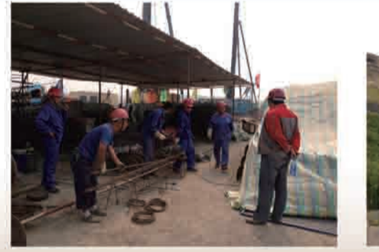
亳州板集钢筋笼加工
