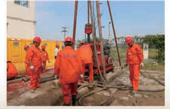
水文钻探施工
