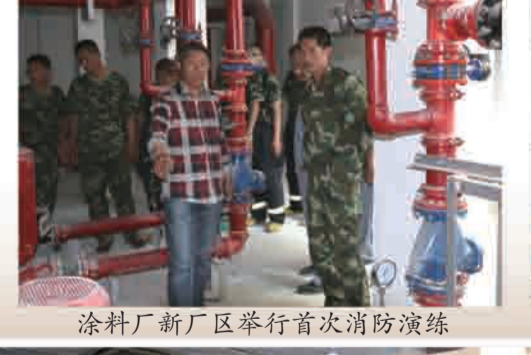
涂料厂新厂区举行首次消防演练
