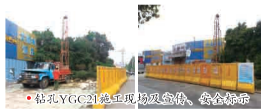
钻孔YGC21施工现场及宣传、安全标示
