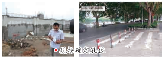
现场确定孔位
