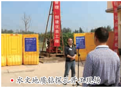
水文地质钻探孔开工现场
