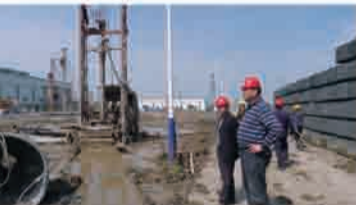
检查基桩公司镇江工地
