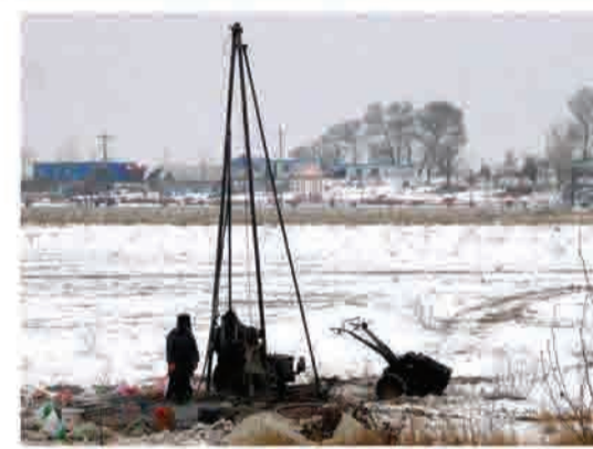
长春至乌斯台铁路勘探野外施工
