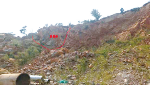
中部崩塌隐患区现状
