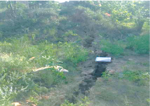
中部隐患区崩塌体裂缝
